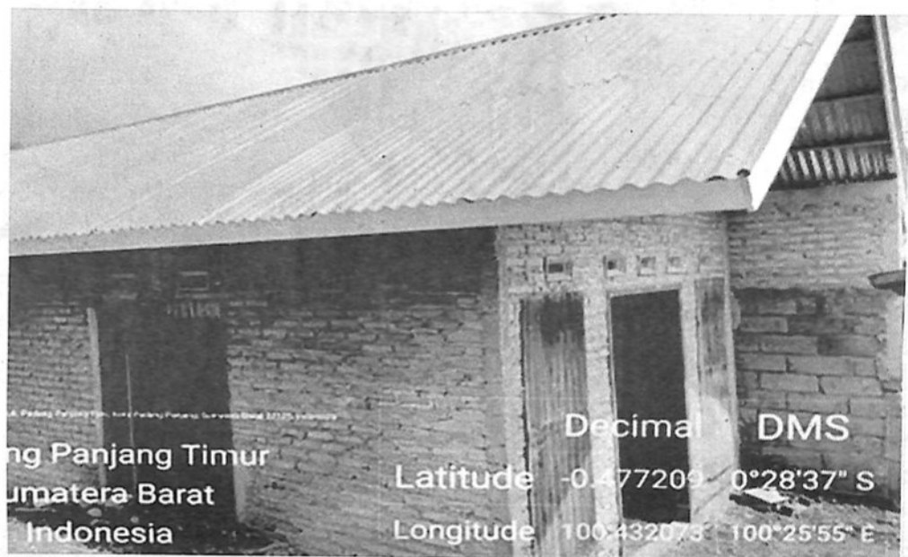
Salah satu rutilahu yang sudah direnovasi.
